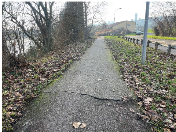
Enrobés - Soulèvement racinaire Maxéville (54)
