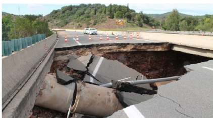
A75 - Effondrement d'une buse à Lodève (34) – Septembre 2015 (source : DIR Massif Central)
