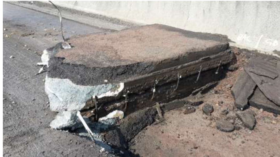
Démolition BAC/GB3 RN 4
