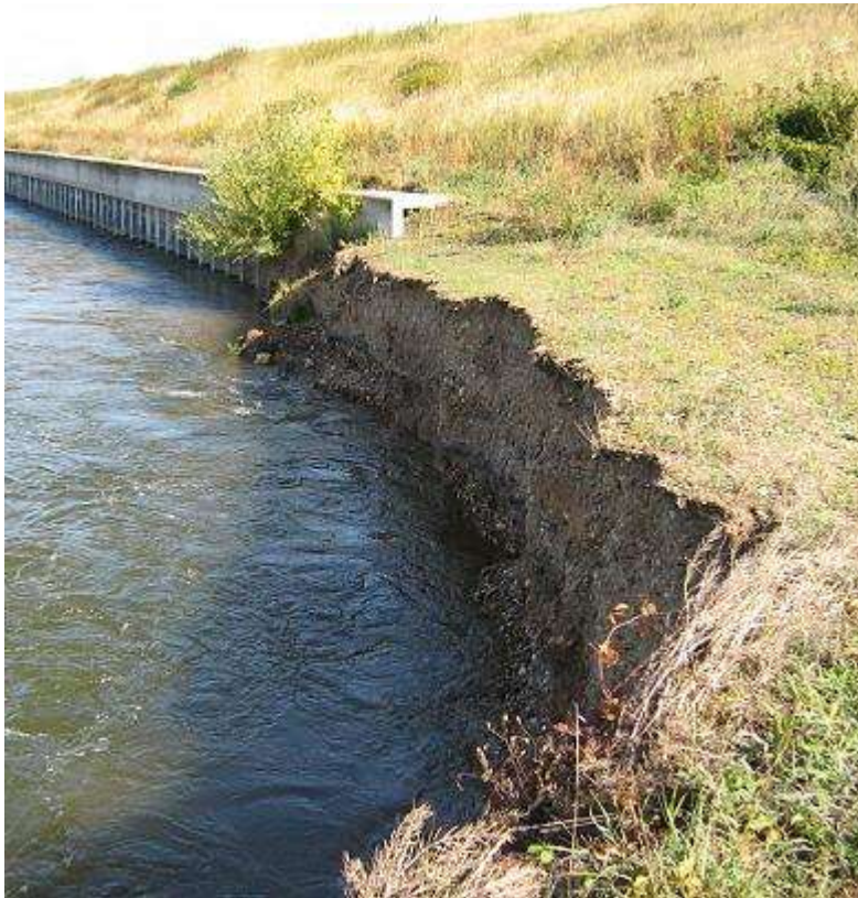
Saint-Benoît-sur-Loire Encoche d'érosion dans la risberme
