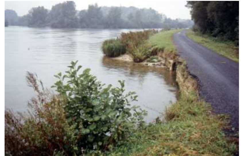
Saint-Benoît-sur-Loire Encoche d'érosion dans la risberme
