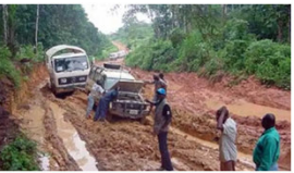
Cas où la latérite a des propriétés mécaniques insuffisantes (Liberia)
