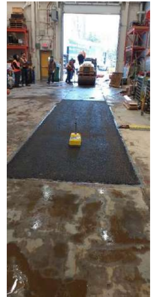
Couche de surface
