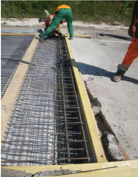
Coulage des poutres d'arrêt
