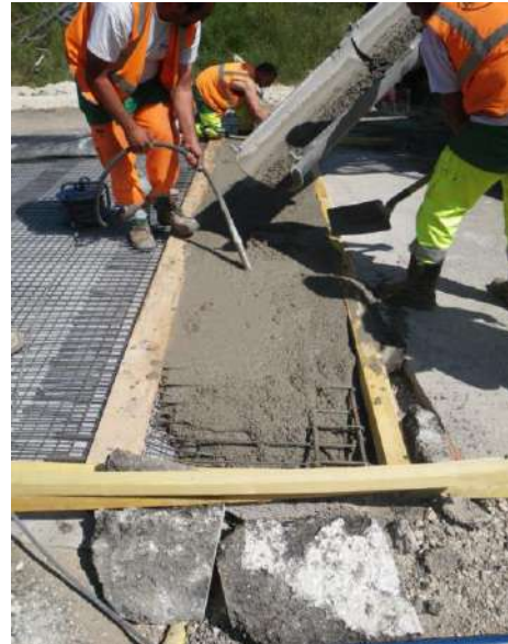
Coulage des poutres d'arrêt
