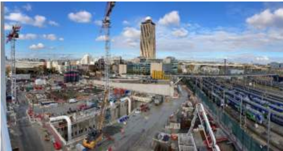
Future gare Saint-Denis Pleyel
