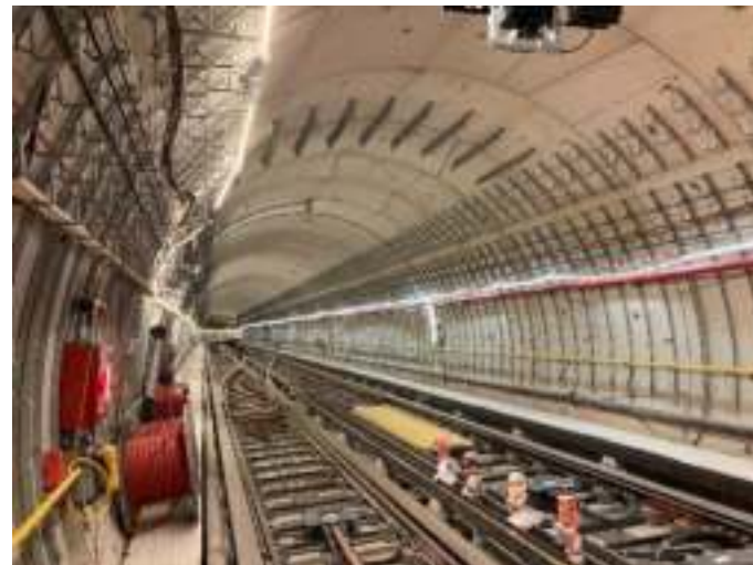
Tunnel de la ligne 15 Sud
