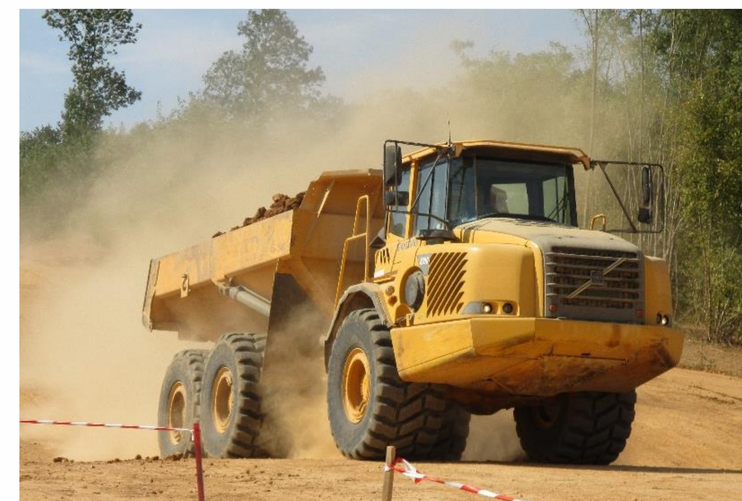
Figure 1 : Poussières générées par la circulation d'un tombereau articulé sur un chantier de terrassement
