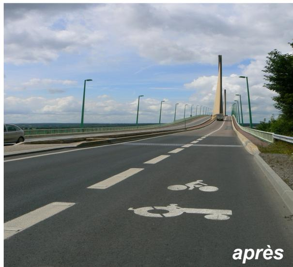
**Pont de Brotonne** : passage de 2x2 voies à 1x1 voie avec réalisation d'une voie mixte engins agricoles et vélos
