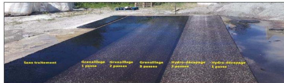
Grenailage après la mise en œuvre pour éliminer le mastic superficiel
